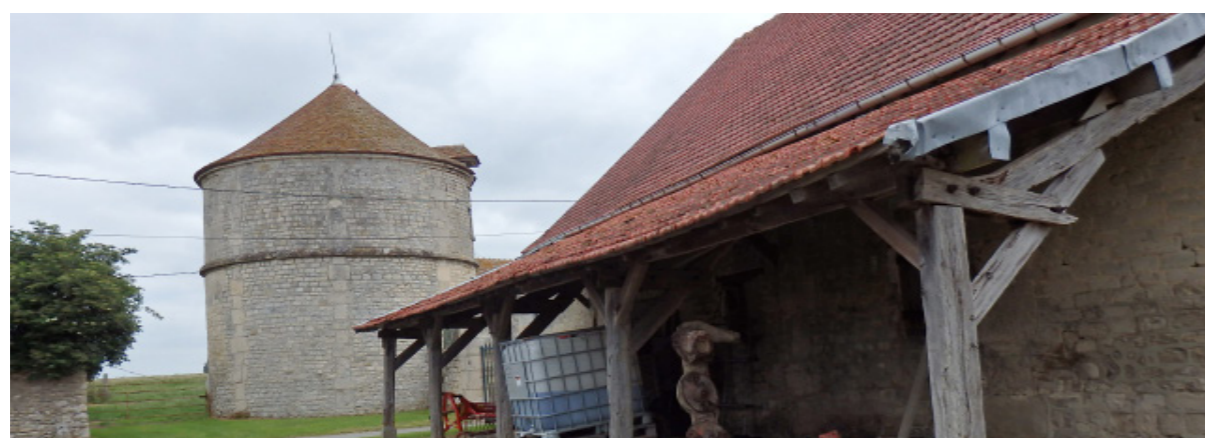
Pigeonnier remarquable, ferme de Neuville, en pierre et tuiles plates avec lucarne à capucine.
