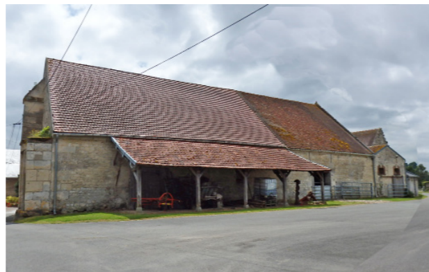
Ferme Neuville : Grange en pierre avec contreforts
