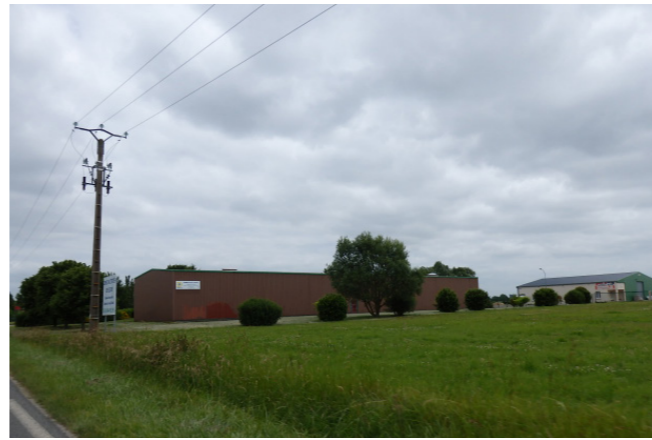
Bâtiments d'activités au centre de la zone d'activités économiques.
