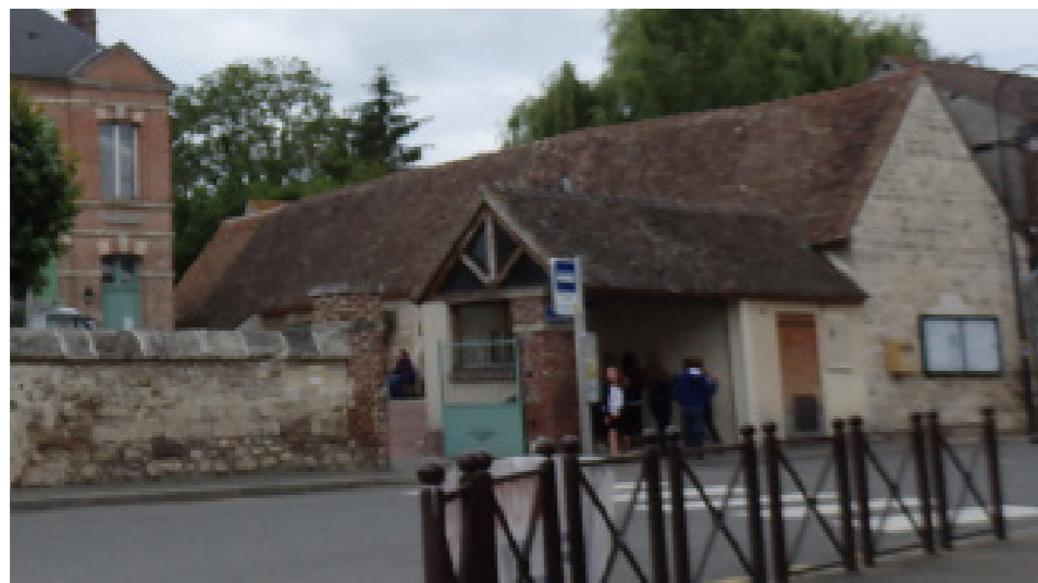
Arrêt de bus centre, face à la Mairie et sur l'emprise de la place de l'Église.
