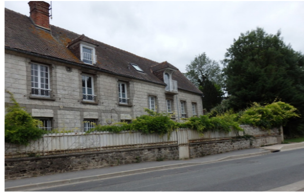
Bâti R+1+combles en retrait de rue et mur en pierre rue du Moulin
