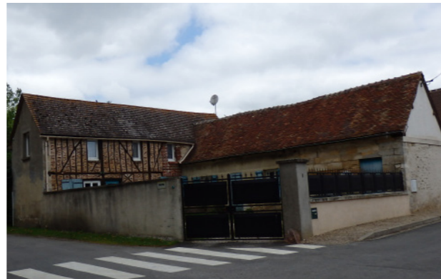
Bâti RDC+combles en pans de bois en retrait de rue et mur de clôture.
