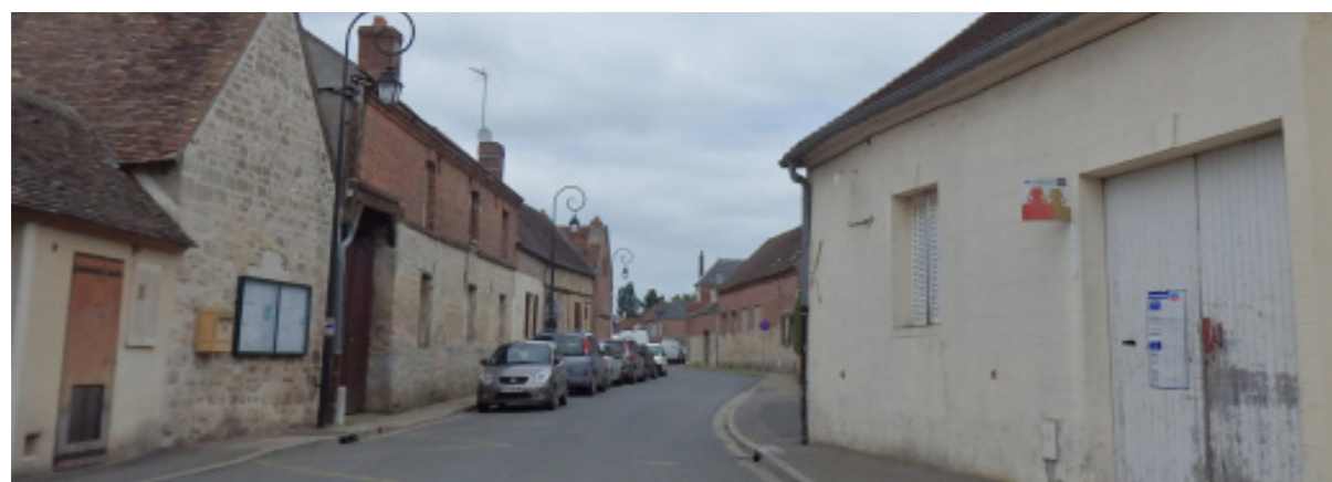
Ambiance de la Grande Rue où les bâtiments à l'alignement de la voie sont constitués de pierre, de brique ou de pans de bois.
