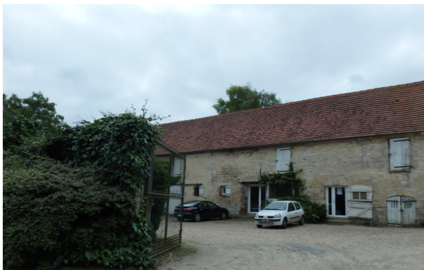
Bâti des corps de ferme R+1 en pierre et tuiles, implanté en retrait de rue
