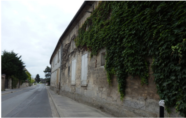
Bâti traditionnel en pierres R+1, implanté à l'alignement de la rue du Moulin
